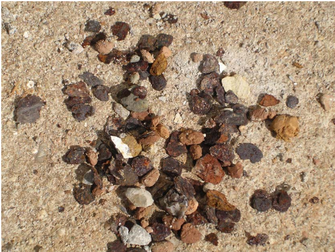
Foto 2.- Restos obtenidos durante la limpieza: arcillas, fragmentos de tubería, cantos calizos.
